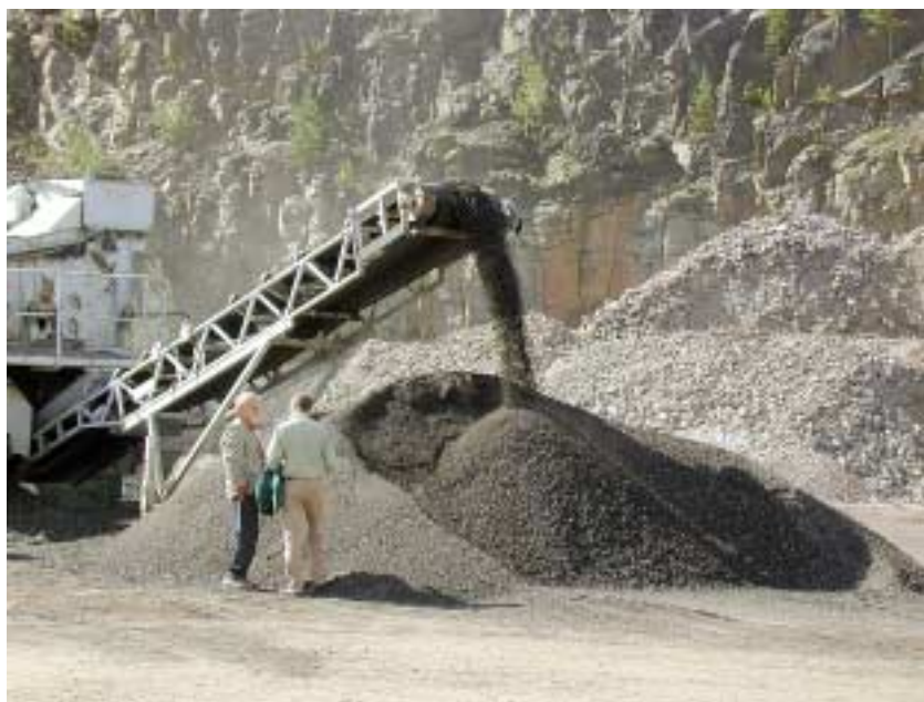
Sorteringsanläggningen i Ramnaslätt tar emot restmaterial från bygg- och anläggningsindustrin i Borås med omnejd. Här sorteras materialen, t.ex. asfalt, schaktmassor och krossad betong, för återvinning eller deponering. I framtiden bör en allt större andel kunna återanvändas. För detta krävs tydliga krav på funktion och miljöegenskaper samt anpassade testmetoder.
